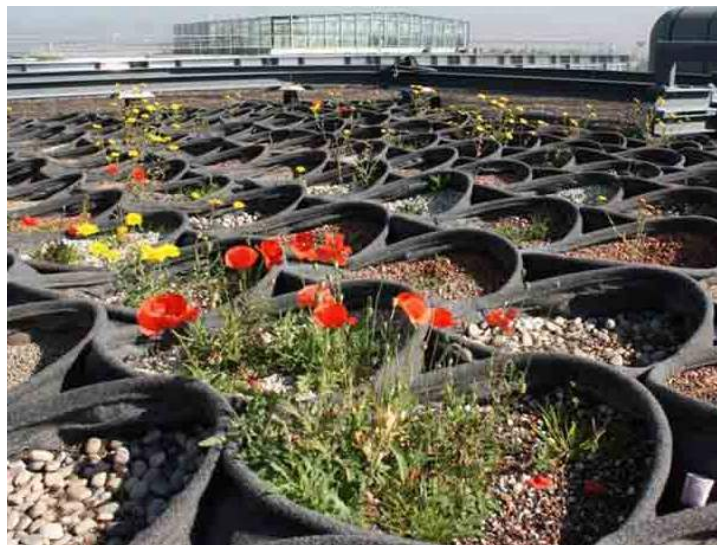
Figura 2.13 - Cobertura verde, utilizando o método modular, saco (W12)
